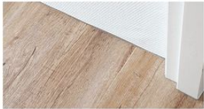
PVC vloer zonder plint, gekit met siliconenkit trijs
