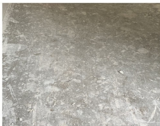
5 - Ernstige vervuiling, waarbij te denken valt aan olie-, was-, lijm-, verf- en stucresten:
