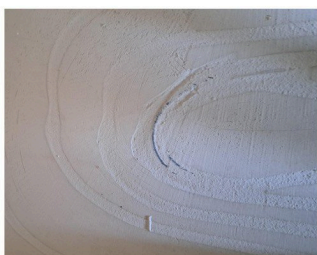
9 - Niet correct aangebrachte ingefreesde vloerverwarming:
